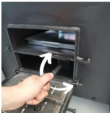
Figura 25. Curățarea tubulaturii cazanului
