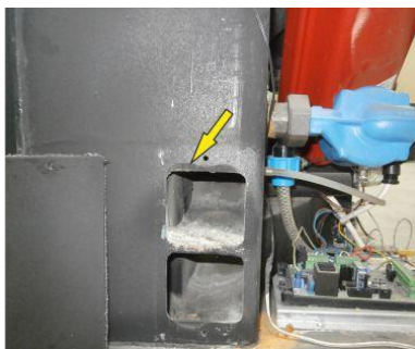
3) pentru modelul de 25 kW – curățarea gudronului de pe țevile de fum prin gura de revizie de ambele părți ale șemineului.
