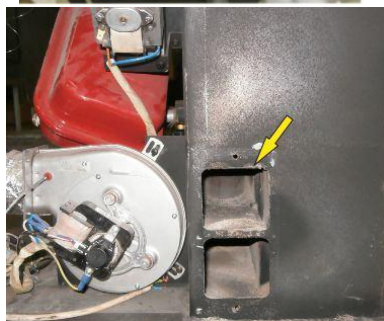
3) pentru modelul de 25 kW – curățarea gudronului de pe țevile de fum prin gura de revizie de ambele părți ale șemineului.
