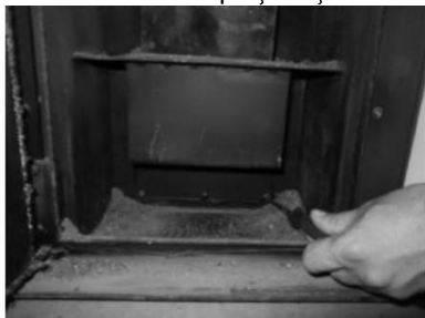
3) pentru modelul de 25 kW – curățarea gudronului de pe țevile de fum prin gura de revizie de ambele părți ale șemineului.
